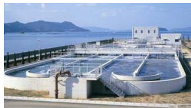
水処理プラント
